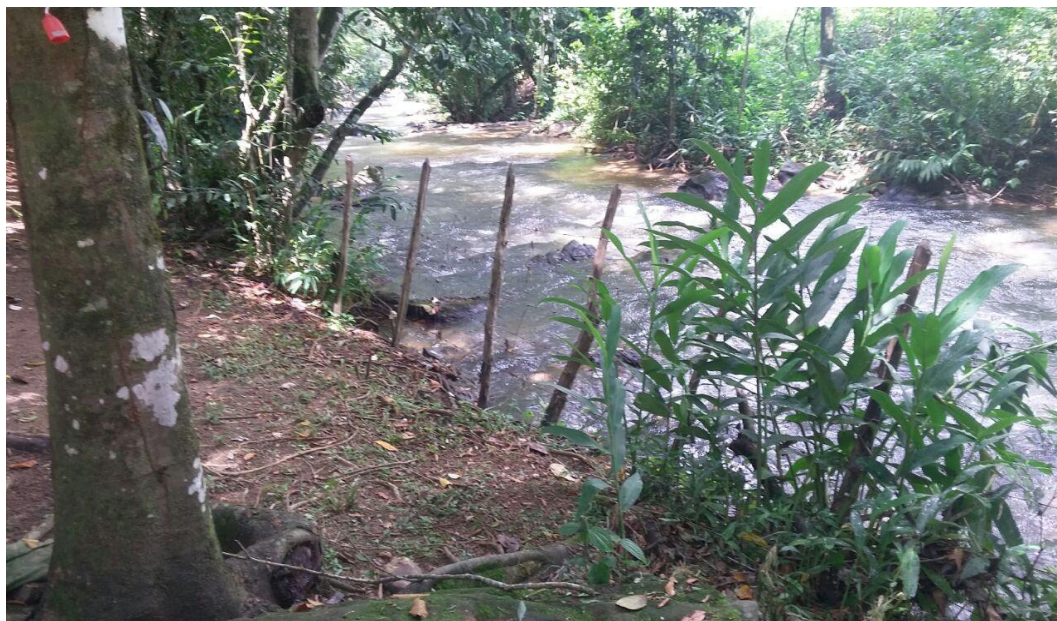
Figura 10. Assoreamento do corpo hídrico no Camping do Mágico.
