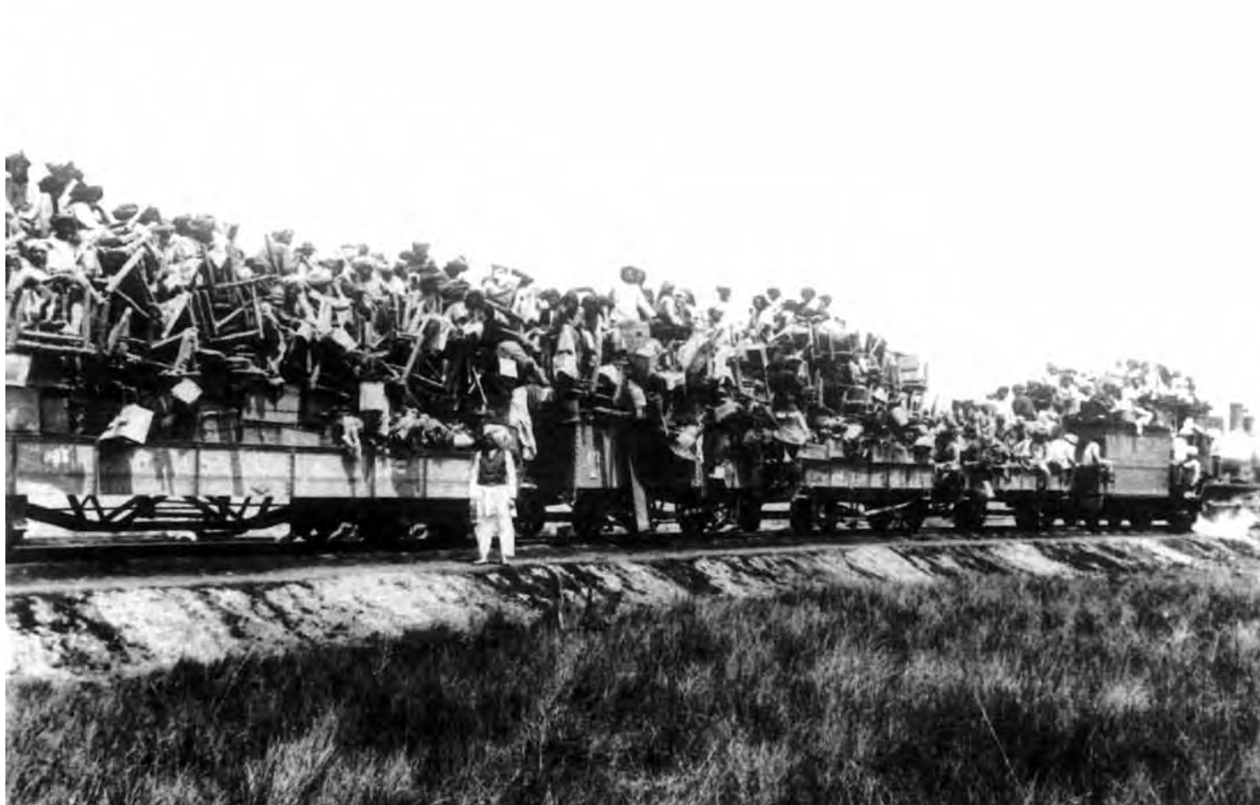
FIGURA 7.2 Equipe volante de assentadores de dormentes na construção da estrada de ferro de Uganda. (Fonte: Royal Commonwealth Society.)
