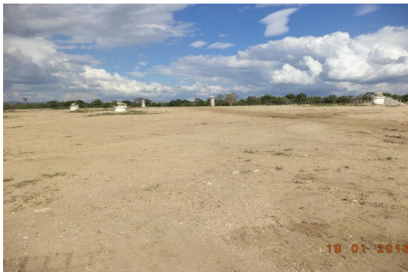
Figura 5. Pontos de Drenagem do Biogás (fonte: Dados da Pesquisa)
