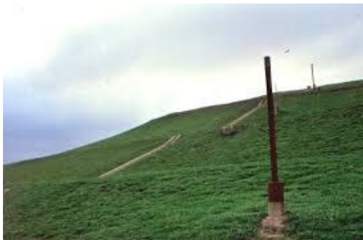
Figura 9. Flare instalados em aterro. (fonte: < http://www.google.com >)
