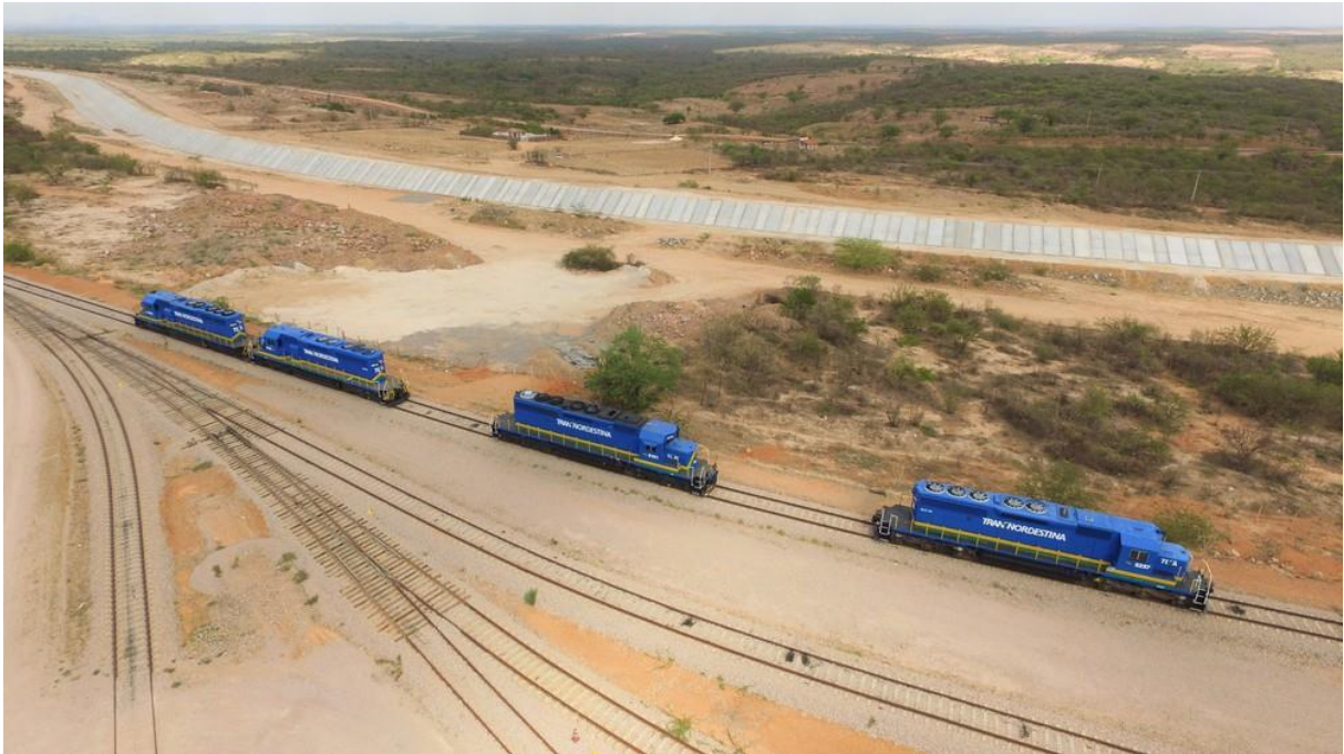
Obras da Transnordestina próximas aos canais da transposição do Rio São Francisco em Salgueiro (PE)
