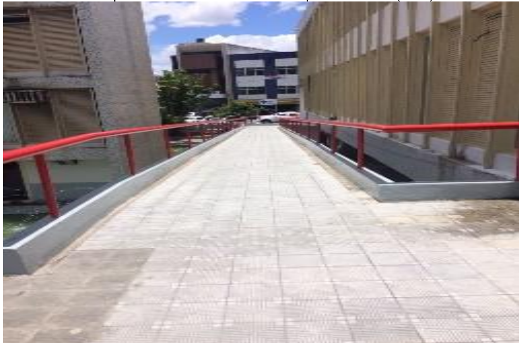
Rampa de Acesso à Prefeitura Municipal de Caruaru (2017).
