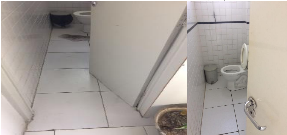
Banheiro do bloco B, Prefeitura de Caruaru (2017).
